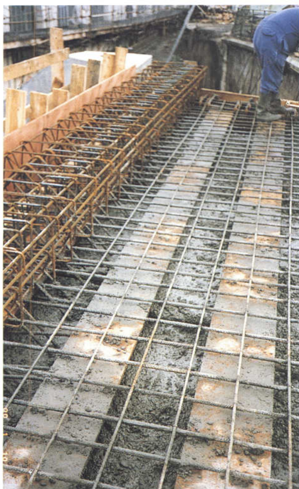
FIG. 68 : Avant-dernière passe de bétonnage
