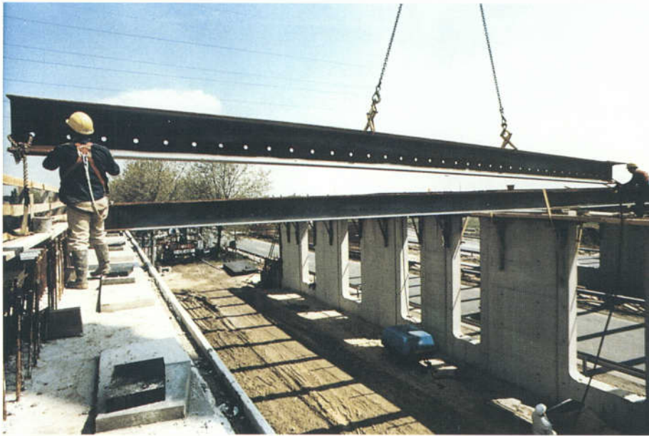
FIG. 53 : Mise en place des poutrelles par une grue
