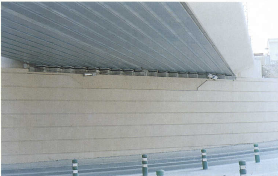
FIG. 27 : Culée et appareils d'appui - Ouvrage fini
