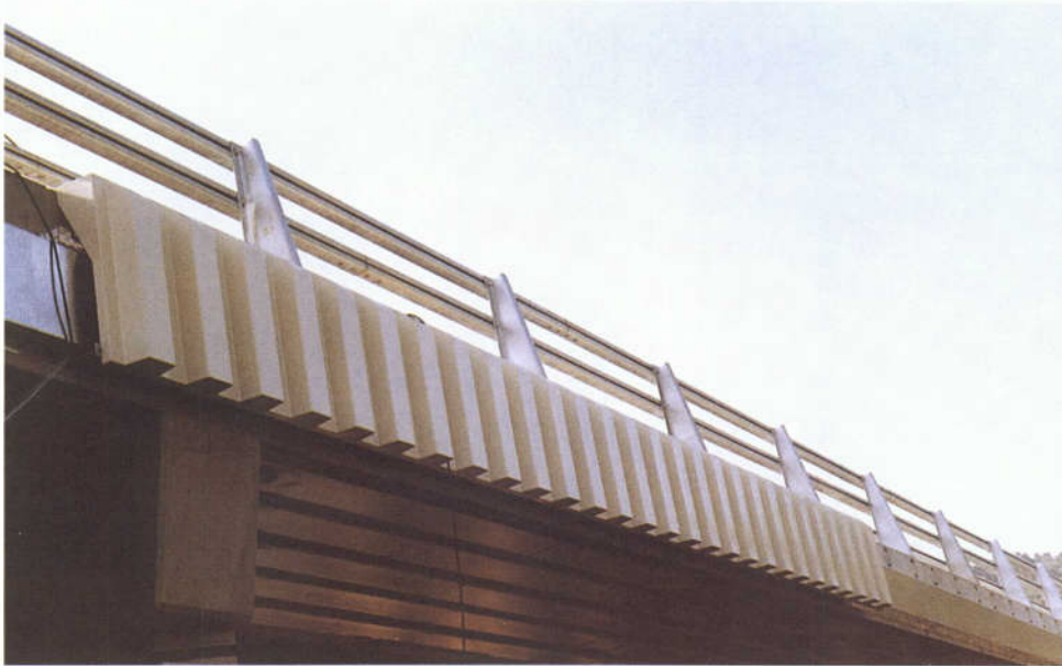
FIG. 37 : Exemple de corniches en matériau composite
