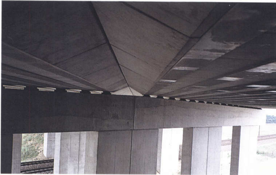
FIG. 3 : Vue de dessous - Tablier - Appuis et appareils d'appui
