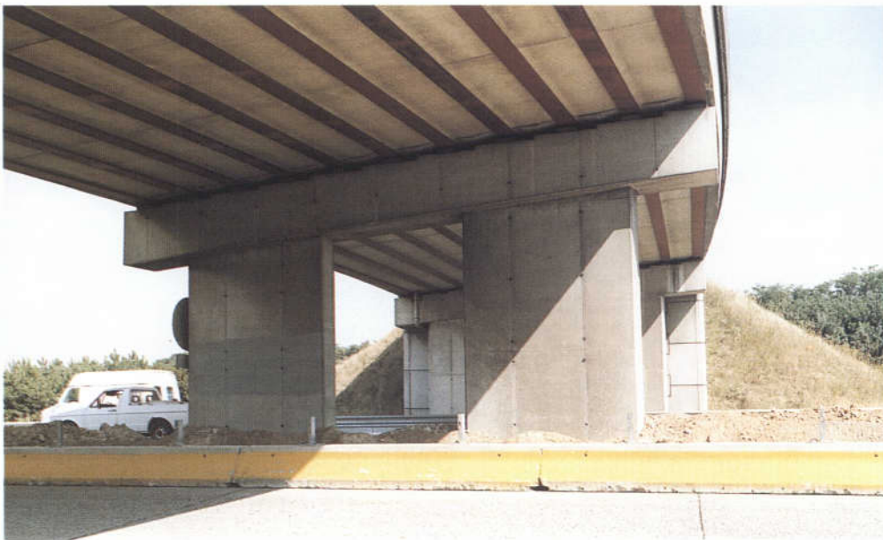
FIG. 8 : Tablier courbe à poutrelles rectilignes
