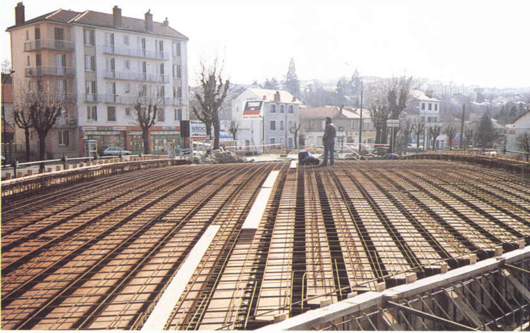
FIG. 23 : Ferraillage (vue générale)
