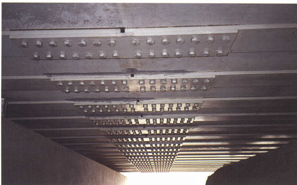
FIG. 6 : Assemblage par couvre - joint
