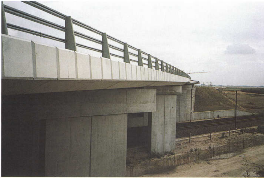
FIG. 35 : Corniches préfabriquées - Ouvrage fini
