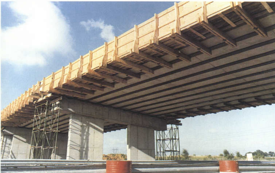
FIG. 55 : Coffrage des bords libres en encorbellement
