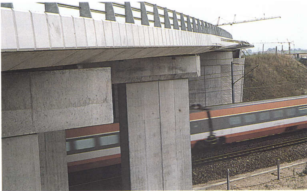
FIG. 1 : Vue générale - Tablier et appuis
