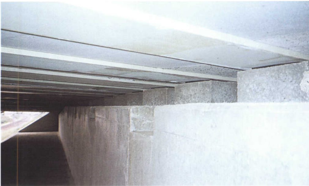
FIG. 25 : Détail des bossages sous poutrelles
