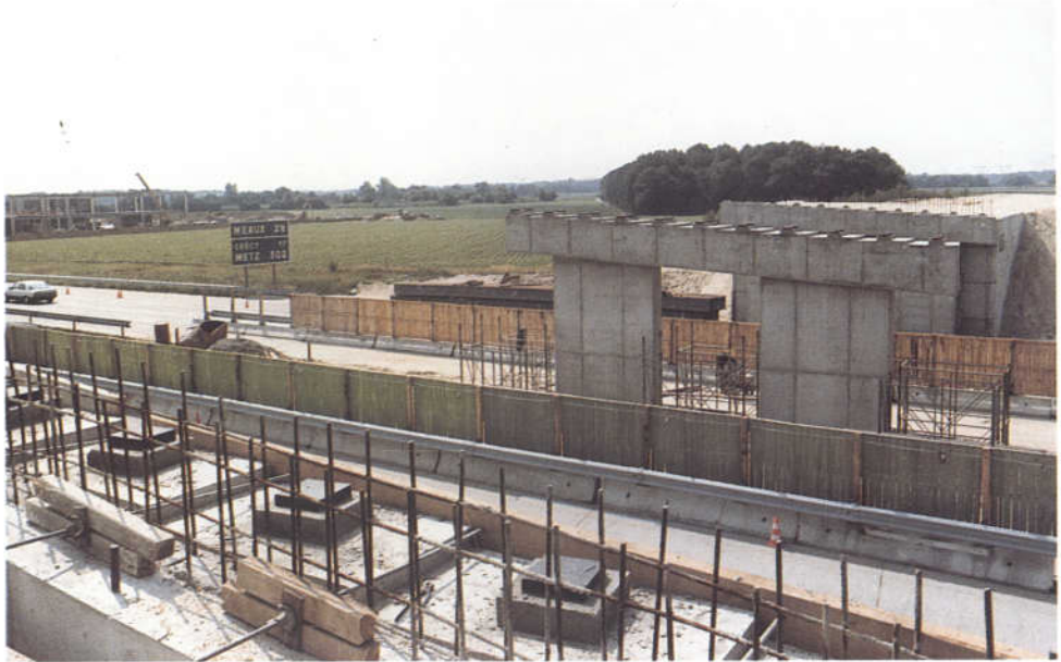
FIG. 24 : Appuis - Appareils d'appui mis en place sur des bossages
