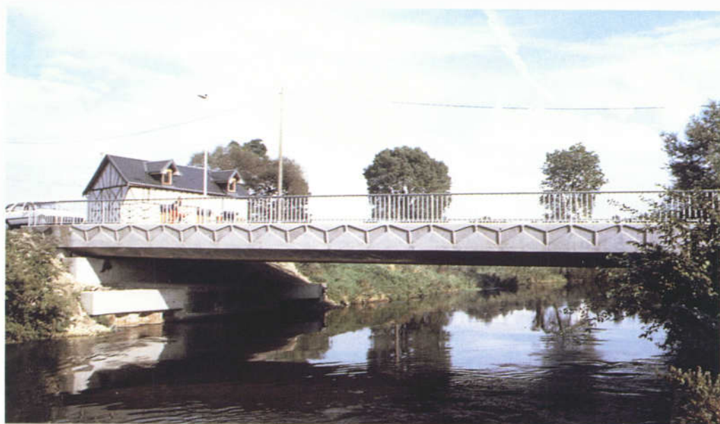
FIG. 45 : Ouvrage hydraulique à poutrelles enrobées
