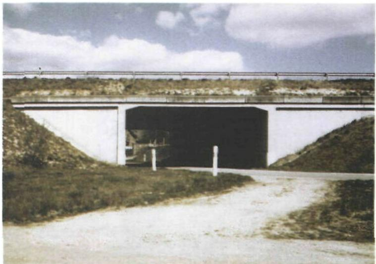
Au-delà de cette limite, l'ouverture maximale économique décroît lorsque le remblai devient de plus en plus haut. A titre d'ordre de grandeur une hauteur de remblai de 3 m peut être considérée comme un maximum économique pour une ouverture de 8 m.
