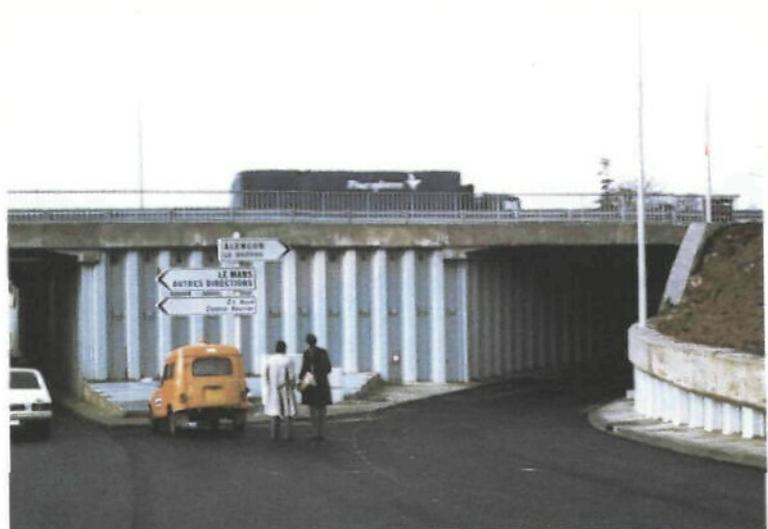
Ces exemples montrent l'incidence de l'implantation des appuis sur le choix du type d'ouvrage ainsi que sur son aspect général. La figure 12 donne un exemple de conception générale d'un ouvrage dont l'aspect est lourd et opaque. S'agissant d'un passage dénivelé en ville, on aurait pu s'orienter vers une structure continue qui aurait permis de supprimer l'écran en palplanches au droit du musoir et aurait rendu ainsi quasi transparente la brèche franchie.
