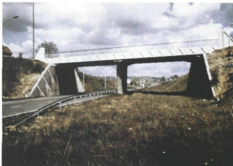
Dans ces cas, il peut être quelquefois nécessaire de masquer par un remblai ou tout autre moyen les parties non fonctionnelles de l'ouvrage, afin de préserver la "lisibilité" de la route en évitant des illusions d'optique préjudiciables à la sécurité.
