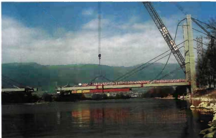
*Photos 54 et 55 : mise en place de haubans préfabriqués*
