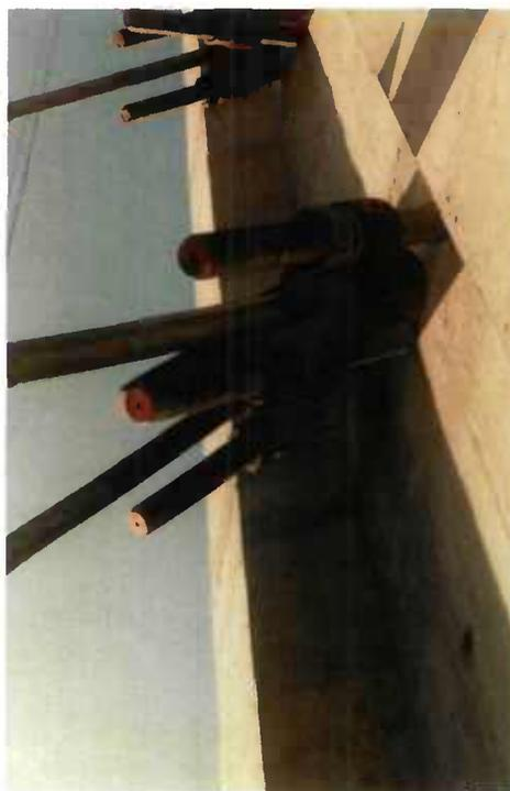
▲ Photo 45 : ancrage haut d'un hauban sur le pont de Seyssel
