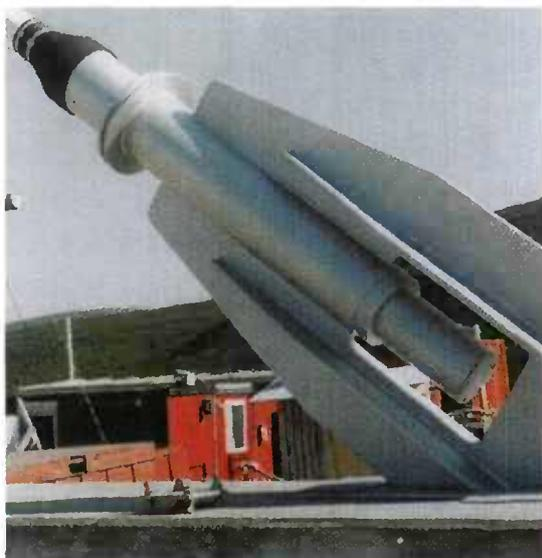
▲ Photo 41 : ancrage bas d'un hauban sur le pont Utsjoki en Finlande – pièce de liaison fixe
