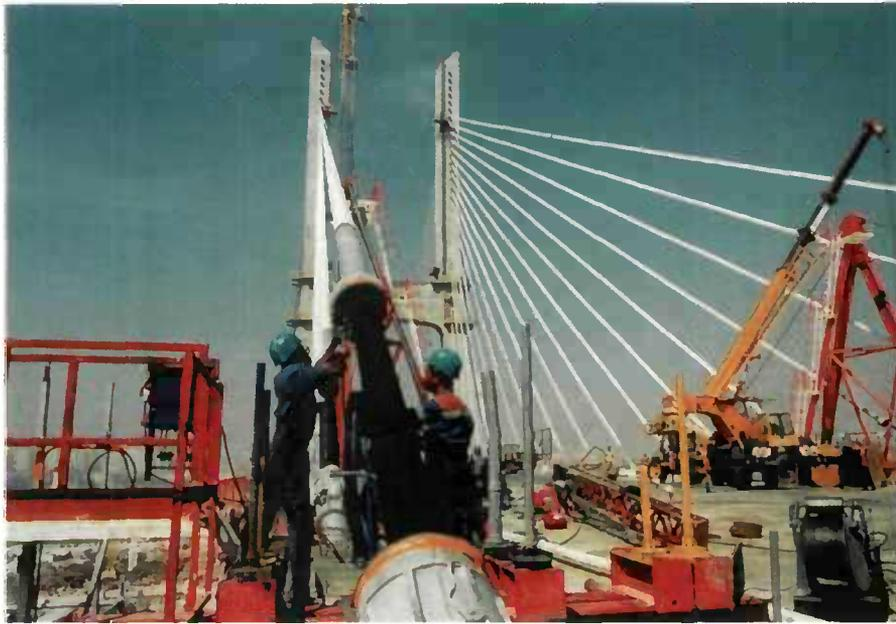
Photo 56 : enfilage toron par toron d'un hauban du pont sur le Tage
