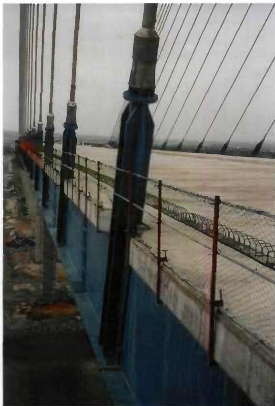
L'orientation des pièces d'attache doit prendre en compte le tracé idéal du hauban (chaînette) dans les conditions de service de l'ouvrage à vide. Les ancrages doivent supporter des déviations angulaires statiques supérieures aux tolérances d'installation des pièces d'attache (voir 12.4.1.)
