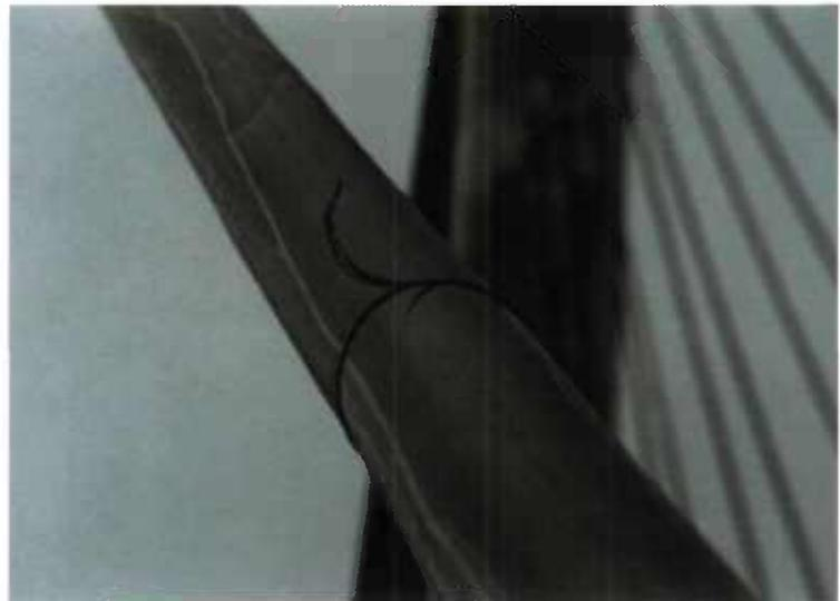
Photos 15 et 16 : rupture de gaine PEHD de type ESC
