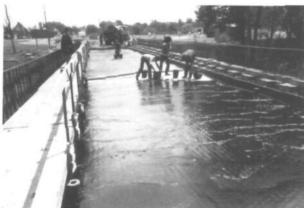
Figure 18 - Etanchéité avec un bicouche asphalte sur papier kraft à trous. Noter l'exécution de pentes vers les avaloirs.
