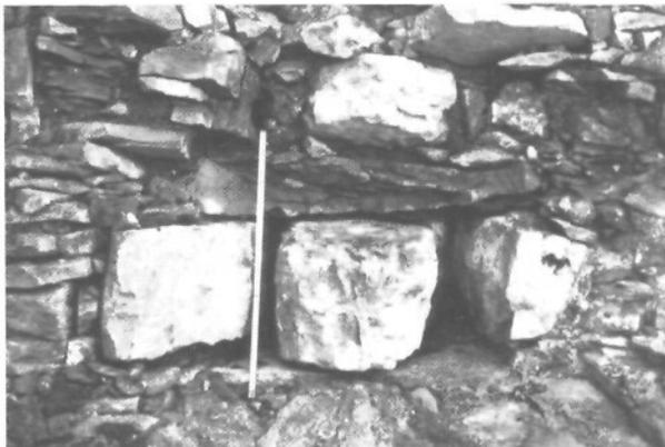
Figure 17 - Quelques aspects de l'état d'une maçonnerie après décaissement complet.
