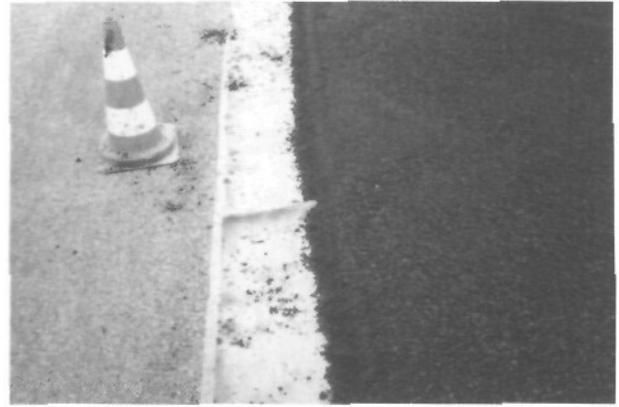
b) L'absence d'adhérence au support entraîne la formation de plis préjudiciables à la tenue de l'enrobé. En outre, lors de la mise en œuvre d'un enrobé chaud, on a observé des fusions de la chape.
