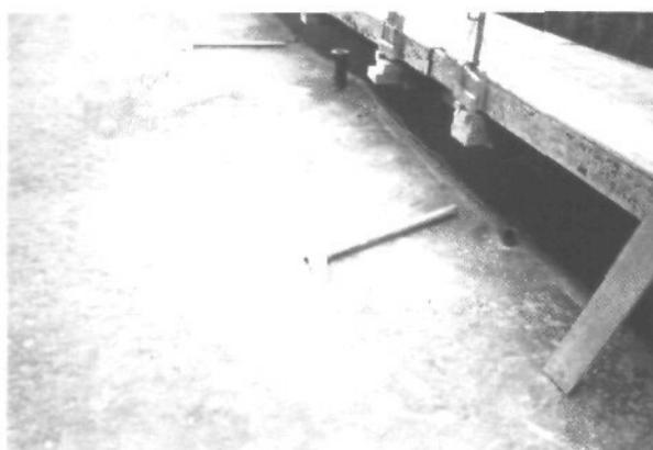
Figure 19 - Mise en place des évacuations comportant une platine pour "prise en sandwich" dans la chape.
