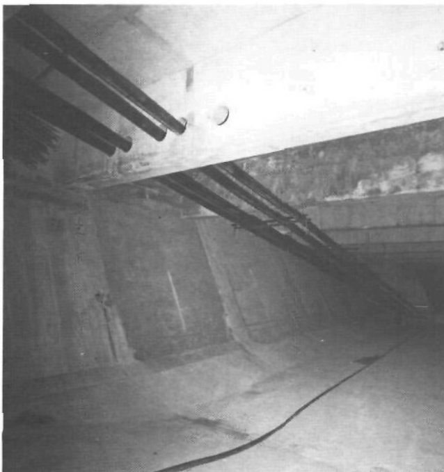
◀ Supports de conduits (photo Y. Blond)
