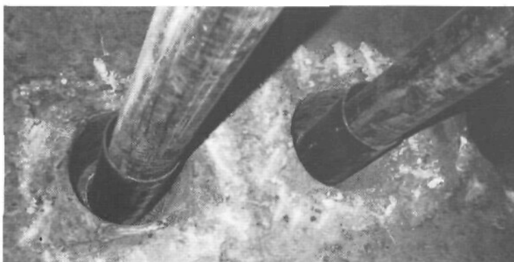
◀ Pour éliminer les difficultés de réglage, on peut utiliser des déviateurs provisoirement mobiles. Après mise en tension, les réservations sont scellées au mortier (photo GTM)
