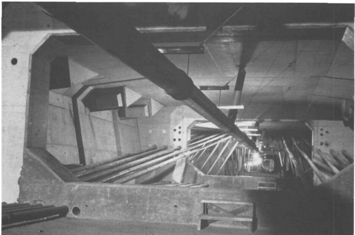
▲ Viaduc de Poncin - Intérieur du tablier (photo C. Servant)
