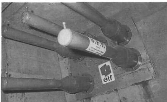
▲ Injection à la cire - Capots longs pour conservation des surlongueurs des torons en vue d'une détension éventuelle (photo A. Chabert)
