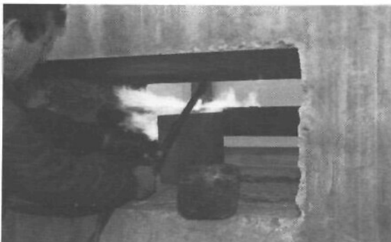
▲ Essai de démontabilité - Étape 1 : tronçonnage du câble (photo R. Chaussin)
