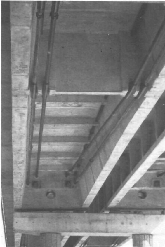
▲ Déviateurs mobiles - Viaduc de Saint-Agnant (photo Freyssinet)
