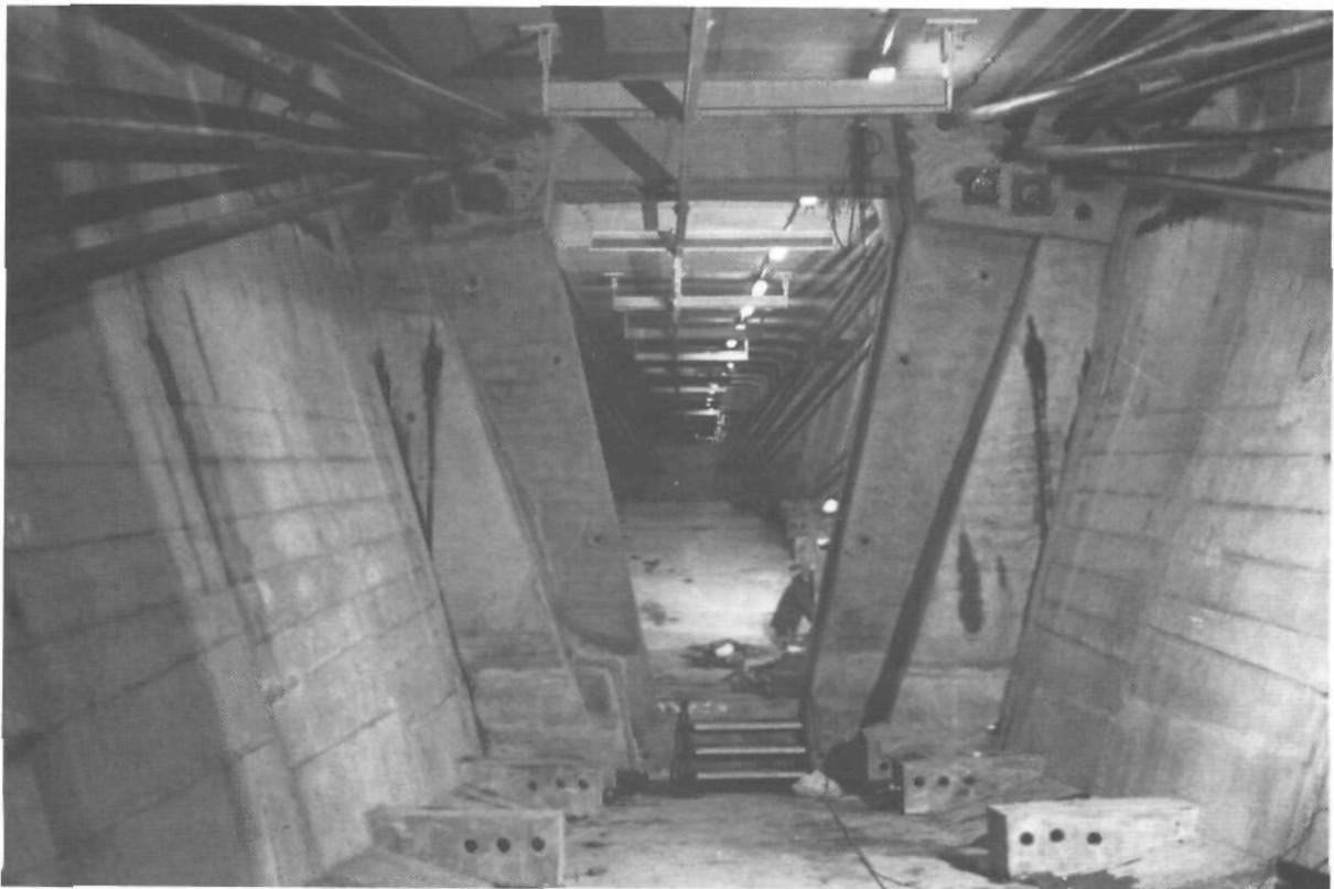
▲ Pont de l'Île-de-Ré - Entretoise d'ancrage (photo G. Forquet)
