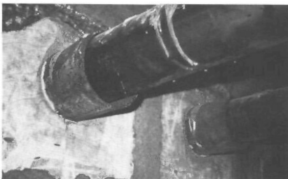
▲ Double enveloppe à la traversée d'un déviateur (photo GTM)
