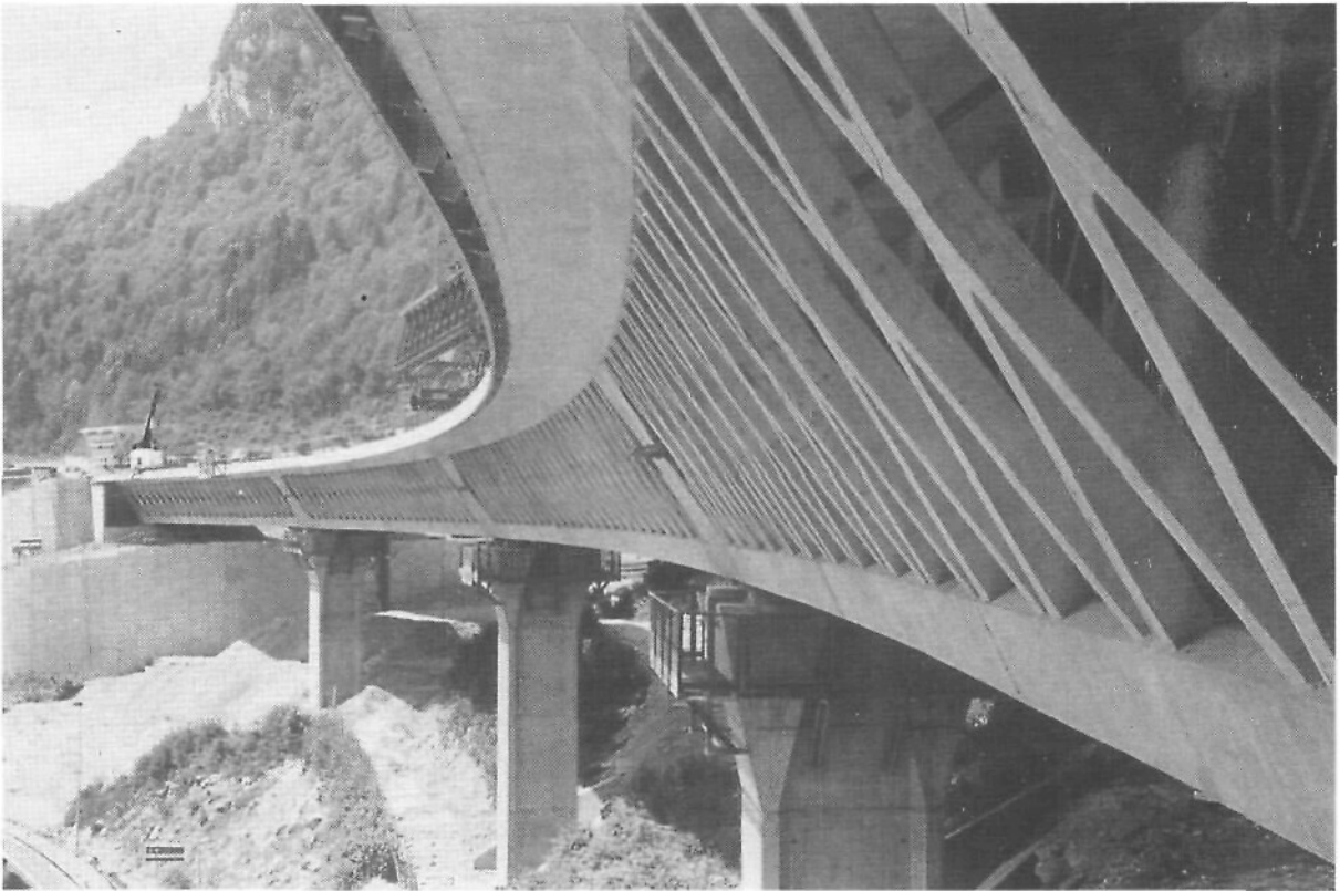
▲ Viaduc de Sylans (photo SETRA)
