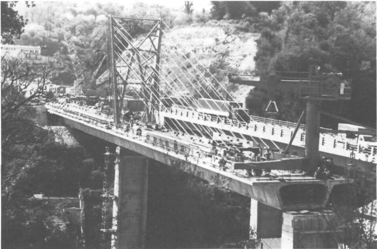
▲ Viaduc du Vallon des Fleurs construit à l'avancement (voussoirs préfabriqués) (photo Campenon Bernard)
