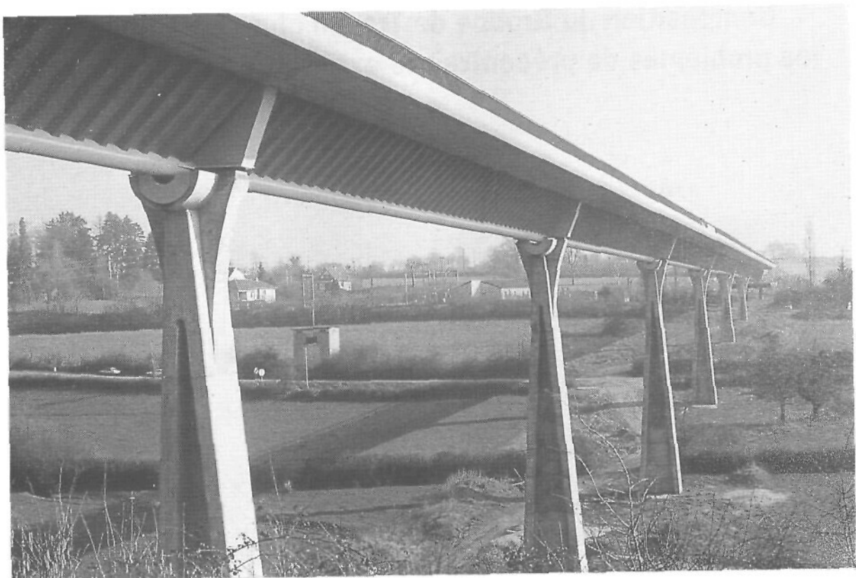
▲ Viaduc du Vallon de Maupré à Charolles - Vue générale (photo Campenon Bernard)
