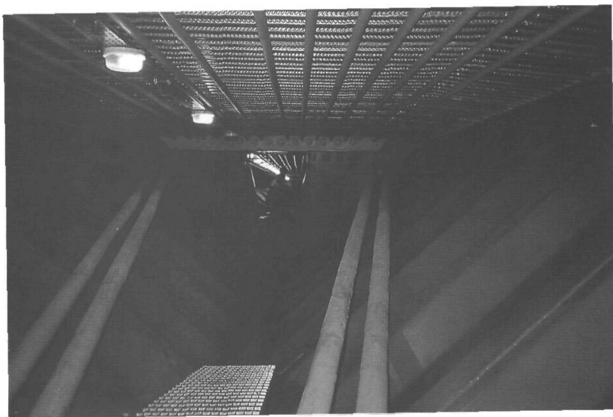
▲ Viaduc du Vallon de Maupré à Charolles - Intérieur du tablier (photo SETRA)
