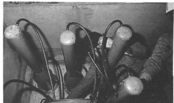
▲ Capots longs - Injection en cours (photo A. Chabert)
