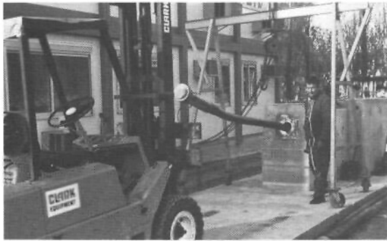
▲ Essai de démontabilité - Étape 3 : extraction du câble (photo R. Chaussin)
