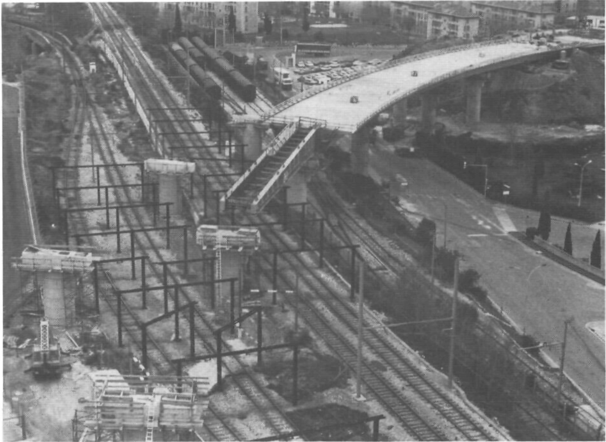
▲ OA 33 à Marseille - Poussage du tablier (photo Dragages et Travaux Publics)
