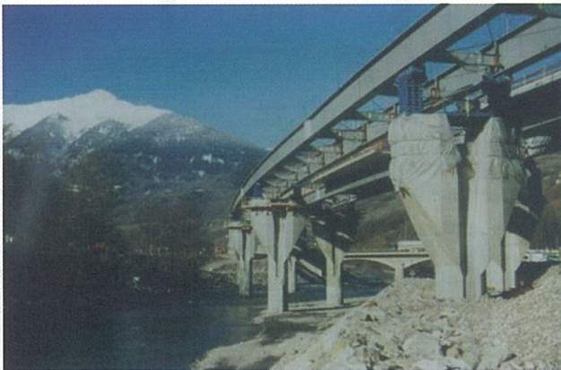
Photo 20 : Ouvrage en construction
