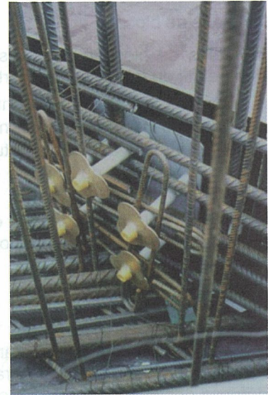
Photo 15 : Ferrailage de diffusion des efforts locaux
