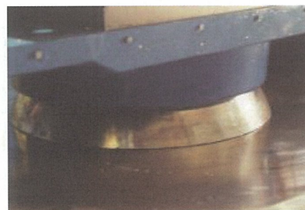
Photo 7 : Dispositifs frottants pendulaires de grandes dimensions utilisés en Californie pour le renforcement parasismique des ponts
