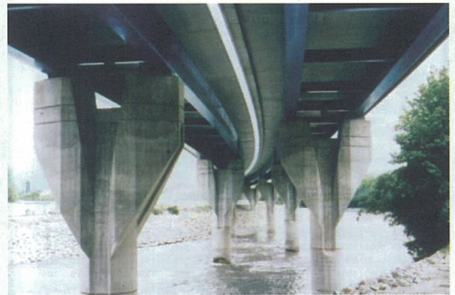
Photo 21 : Piles et sous face du tablier
