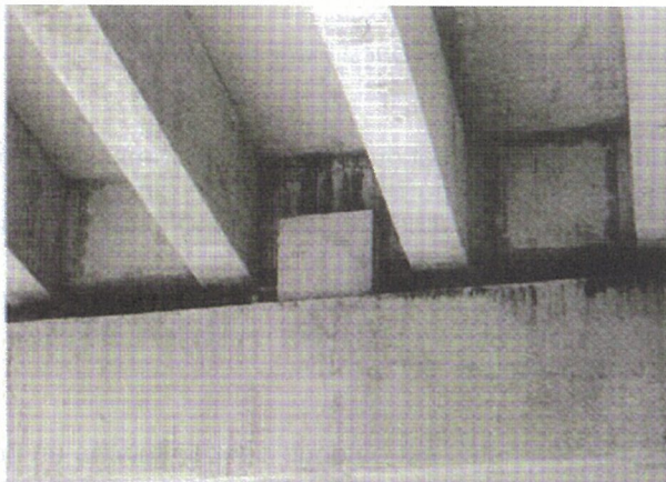
Photo 8 : Exemples de butées béton/béton
