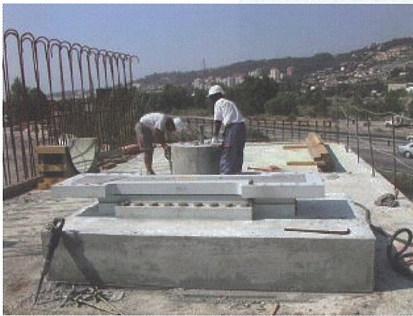
Photo 10 : Exemple de butée en profilé métallique conçu « sur mesure »
