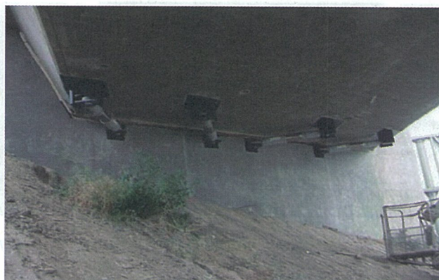
Photo 25 : Autre système de connexion biais pour les amortisseurs
