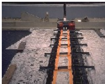
joint de chaussée avant bétonnage (photo Sétra/CTOA)
