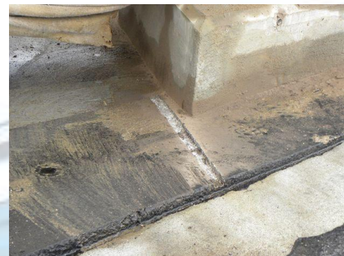
Reprise du Tablier sud détail des évacuations
