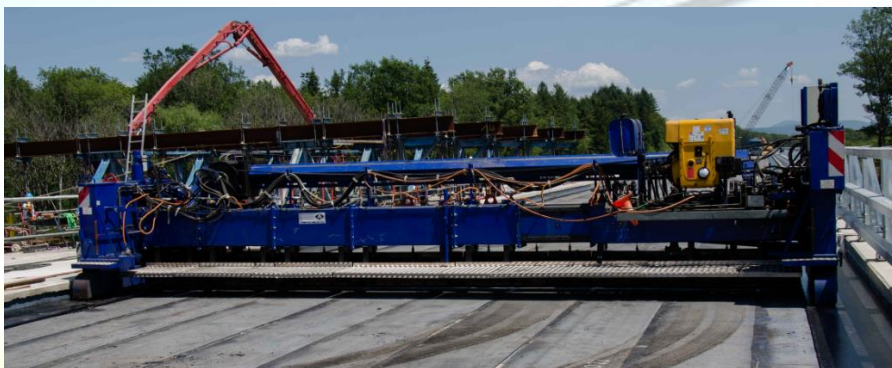
Vue du finisseur utilisé pour la pose de l'asphalte gravillonné (Photo M.Baccara DIR est)
