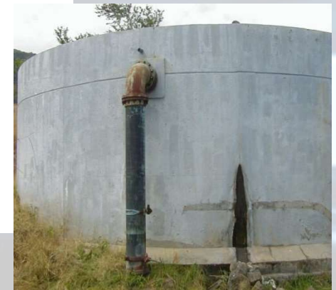
Fuites d'eau d'un réservoir 21
