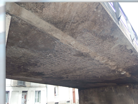
Incendie sous un pont dalle en béton armé
