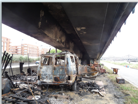
Incendie sous un pont dalle en BP à deux nervures
