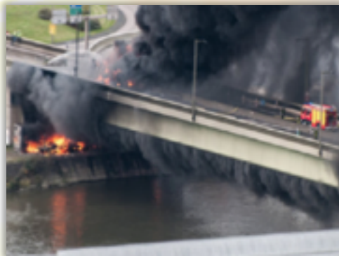
Incendie sur et sous une dalle orthotrope
