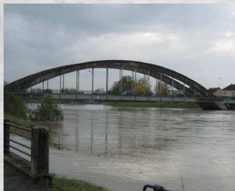
Ouvrage sur une « rivière de plaine » au débouché hydraulique largement dimensionné (photo: LR de Blois)
