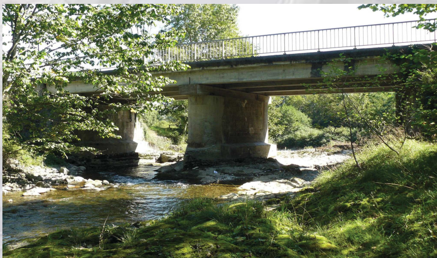
Exemple d'ouvrage sur fond rocheux (photo: DIR Atlantique)
