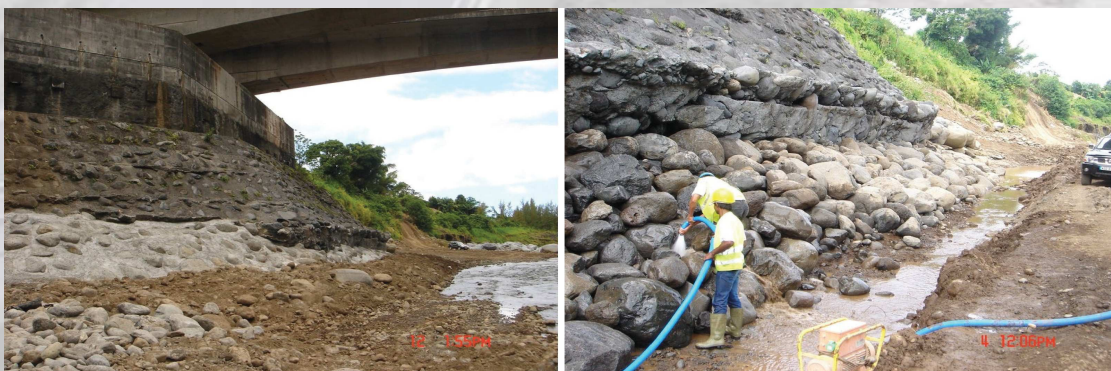
Protection d'une culée de pont (rivière du Mat – La Réunion)
