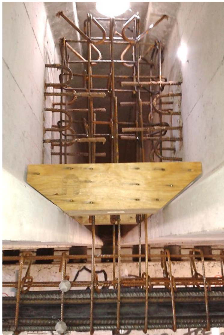
Mise place des ferrillages
