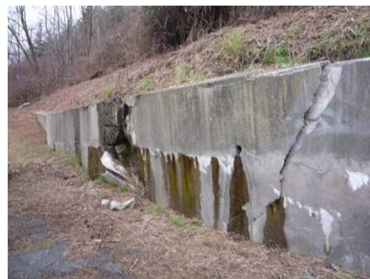
État du mur en mars 2011
