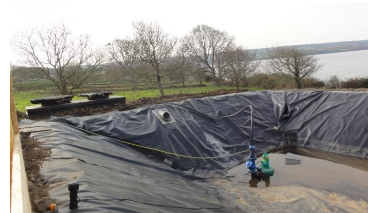
Gestion des eaux pluviales de la base vie
