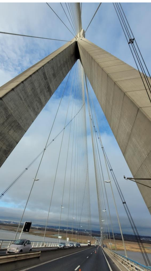
Pont de Normandie
