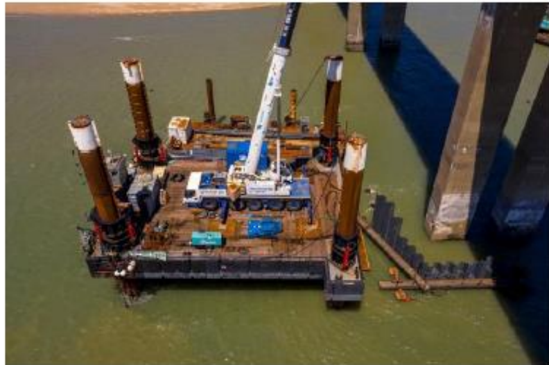
Figure 4: Ponton Cézembre (+ grue télescopique)
