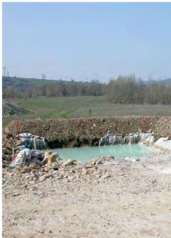
Partie 4 - Photo 13 : bassin de stockage des eaux de rinçage des toupies de béton
