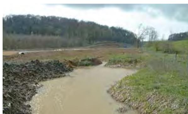
Partie 4 - Photo 10 : perturbation en phase travaux : entraînement de matières en suspension d'un chantier routier dans un plan d'eau
