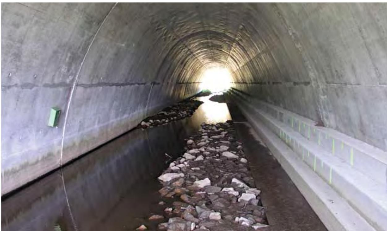
Partie 4 - Photo 5 : à droite, les marches servent pour le passage de la loutre en période de hautes eaux ; à gauche, le boîtier vert contient un appareil photo infrarouge à thermoluminescence qui prend des photos de loutre automatiquement la nuit – Source : D. Legleye (CETE de Lyon)
