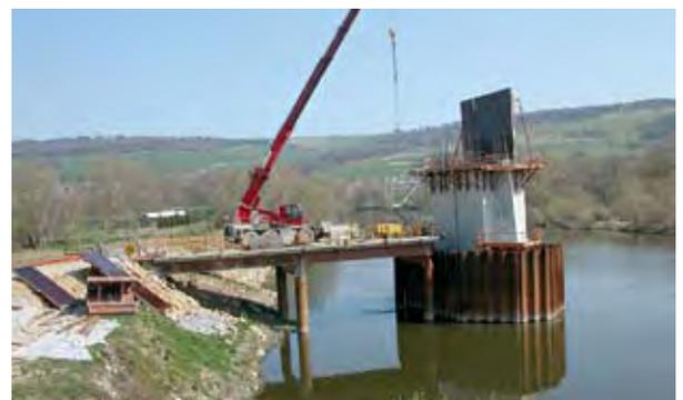
Partie 4 - Photo 3 : un ouvrage provisoire pour accéder à la pile du pont générera moins d'impact qu'un remblai partiel du lit mineur – Source : M. Gigueux (CETE de l'Est)
