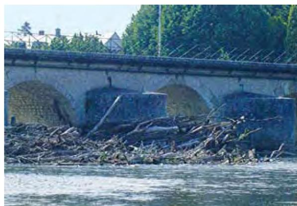
Partie 2 - Photo 2 : accumulation de débris végétaux contre les piles d'un pont sur le Cher – Source : D. Goutx, S. Piney (CETE Normandie-Centre - LRPC Blois)
