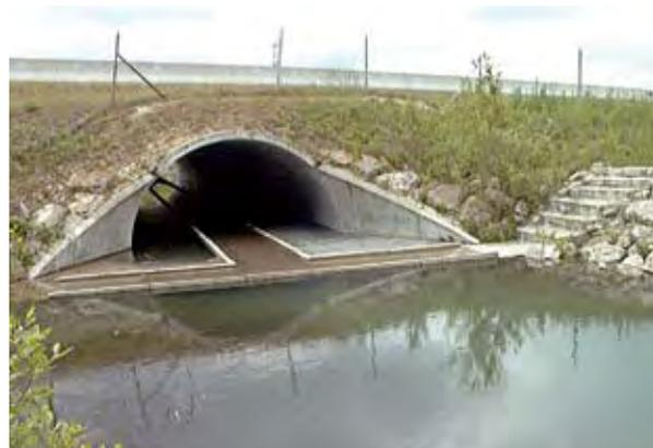
Partie 4 - Photo 1 : exemple d'incompatibilité ouvrage/passage pêcheurs (désordres hydrauliques engendrés par passage pêcheur rajouté à l'ouvrage) – Source : M. Gigleux (CETE de l'Est)
