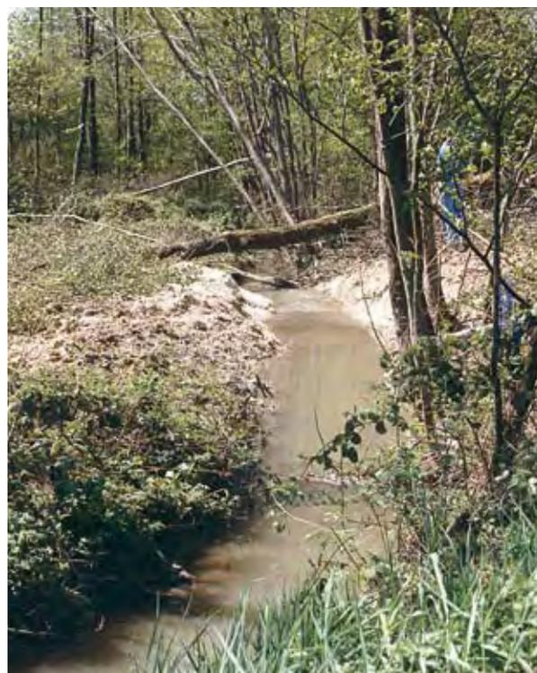
Partie 4 - Photo 7 : exemple de perturbation d'un milieu aquatique en phase travaux : traversée à gué d'un ruisseau à truites par les engins de chantier – Source : M. Gigeux (CETE de l'Est)
