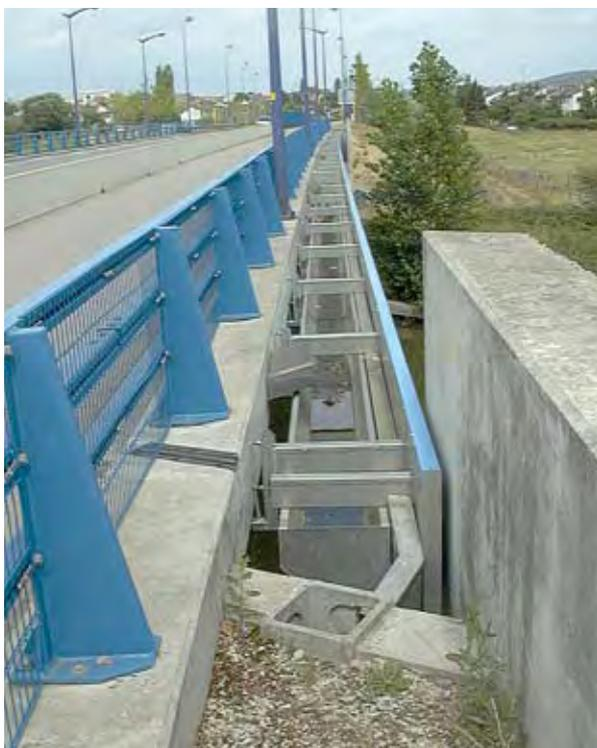
Partie 4 - Photo 6 : corniche-caniveau sur un pont, recueille et évacue les eaux de ruissellement de l'ouvrage vers un système de traitement adapté – Source : M. Gigeux (CETE de l'Est)
