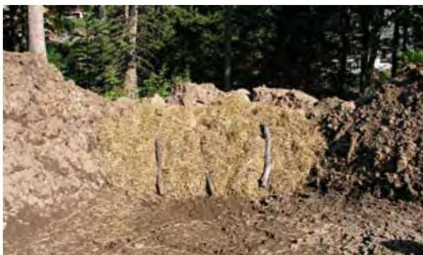
Partie 4 - Photo 11 : filtre à paille à l'exutoire d'un fossé permettant de retenir une partie des fines avant rejet au milieu récepteur
