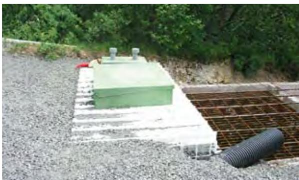
Partie 4 - Photo 12 : mini station d'épuration des eaux usées (boues activées) pour traiter les effluents d'une aire de vie sur un chantier
