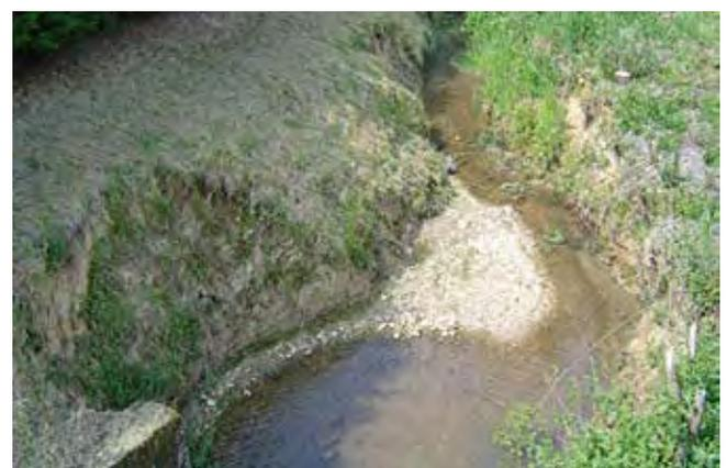
Partie 2 - Photo 1 : encoche d'érosion formée à l'aval d'une buse traversant un remblai routier interceptant un petit bassin versant
