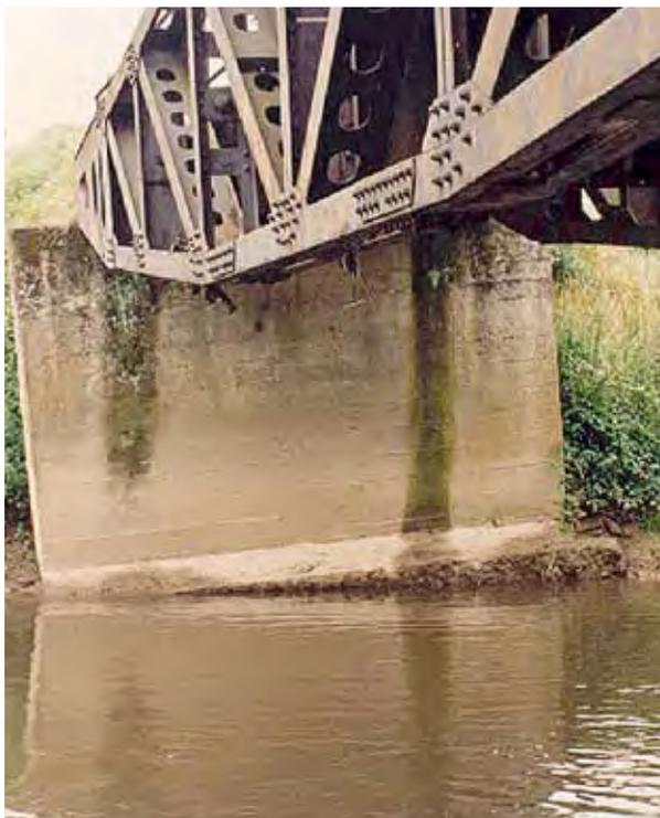
Partie 2 - Photo 4 : pont Farcy sur la Vire, basculement de l'ouvrage d'art sous la poussée des eaux – Source : J.-C. Jouanneau (CETE Normandie-Centre)
