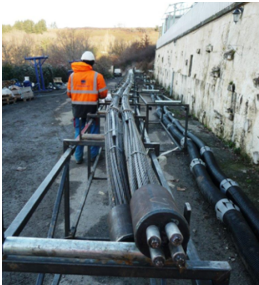
Photo 4.1 : Assemblage sur site de torons (© Freyssinet)
