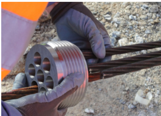
Photo 3.4b : Bloc d'ancrage retensionnable (© Freyssinet)
