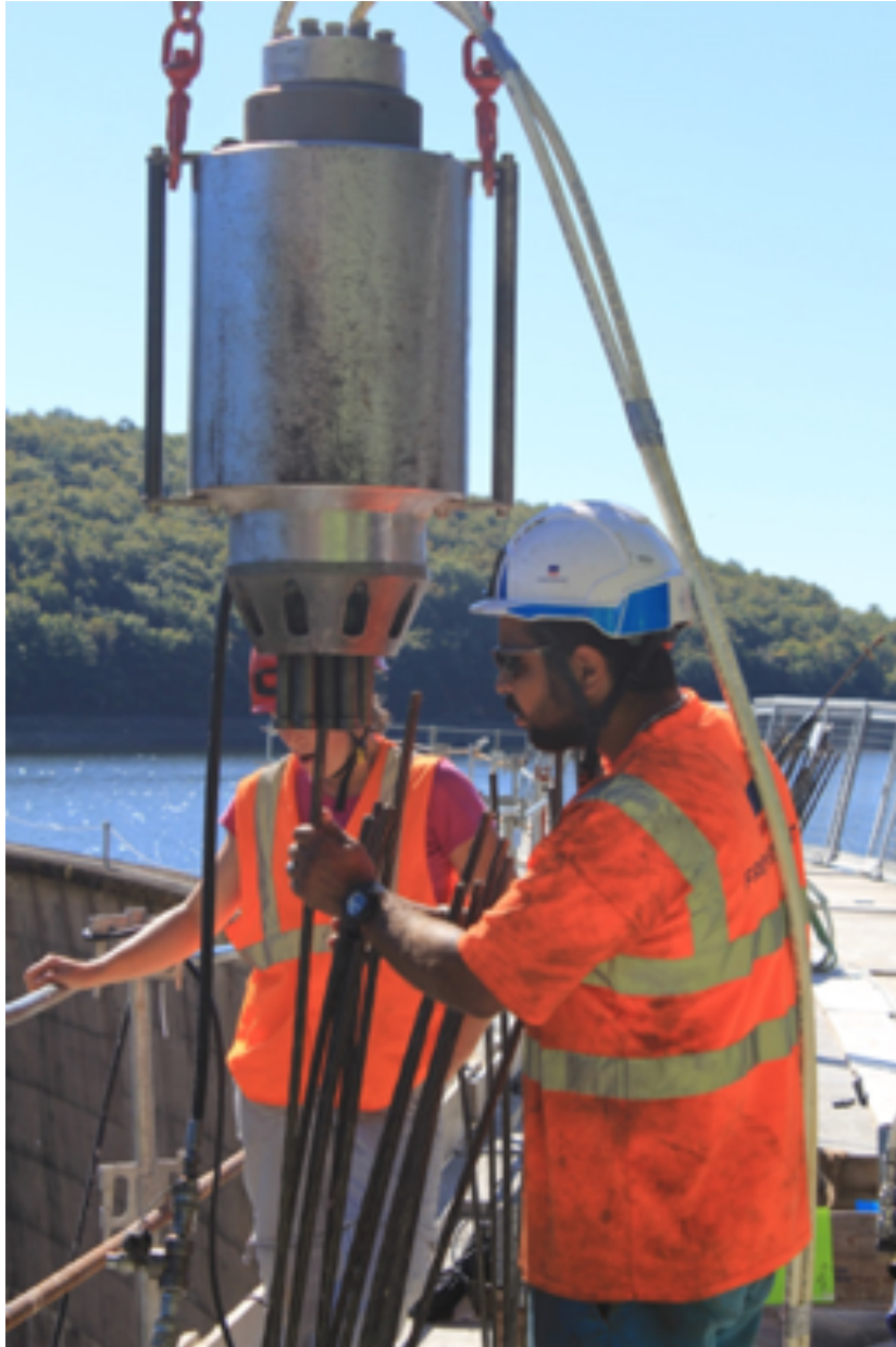
Photo 7.16 : Mise en place du vérin de mise en tension sur un tirant à câbles (© Freyssinet)
