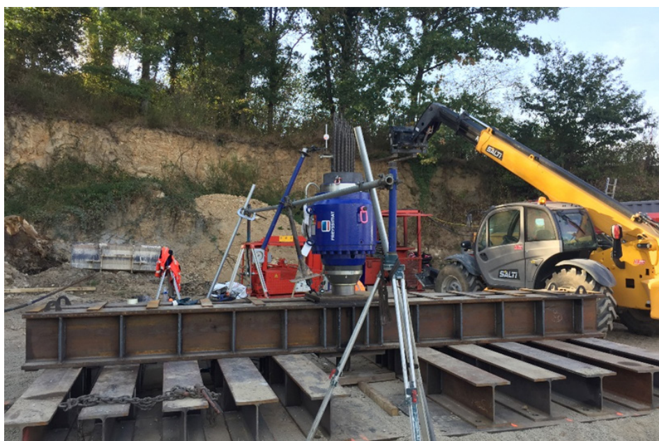
Photo I.1 : Structure d'appui d'essai de chargement (© Soletanche Bachy)
