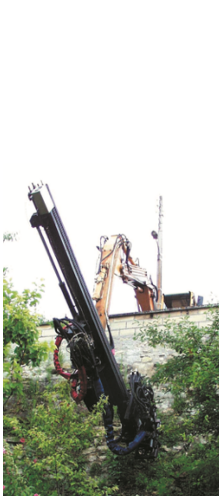
Photo 7.3 : foreuse montée en rétro (© Spie Fondations)
