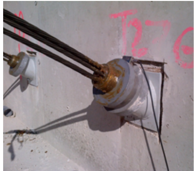
Photo 8.5 : tête de tirant instrumentée (© Freyssinet)
