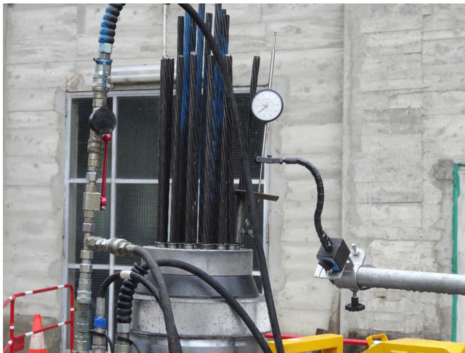
Photo 7.15 : Mesure de l'allongement par un comparateur (© Alexis Piron-EDF)
