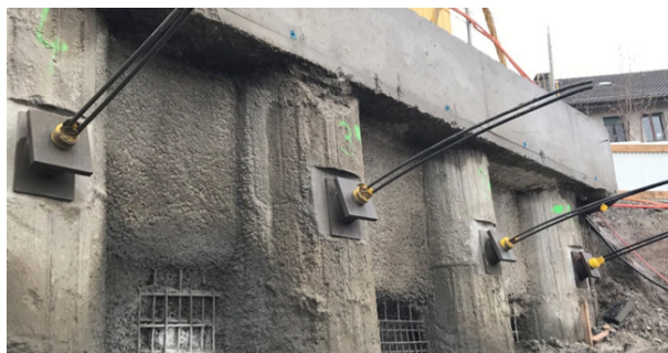
Photo 3.2 : Système d'appui réduit à une cale braise (sur pieu lutécien) © Freyssinet
