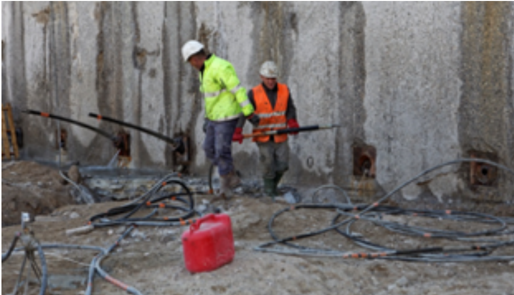
Photo 7.12 : mise en place de l'obturateur (© Spie Fondations)
