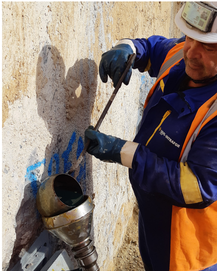
Photo 6.5 : remplissage du tube-trompette de produit anti-corrosion (cire)
