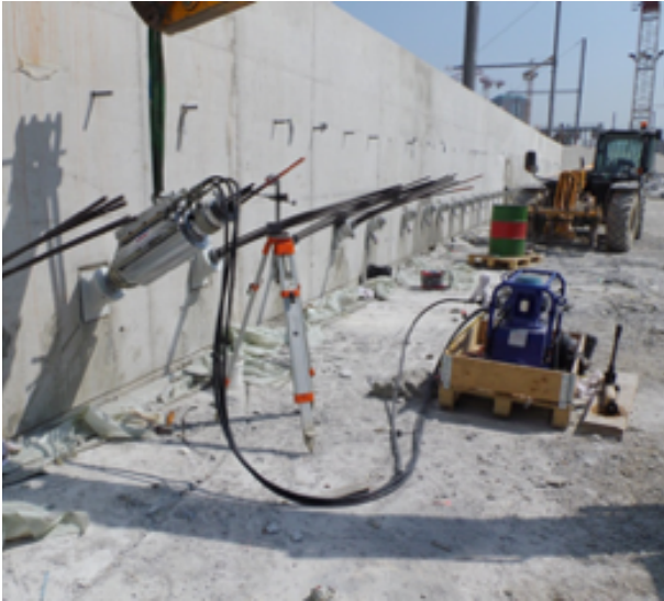
Photo 8.4 : essai de contrôle (© Soletanche Bachy)
