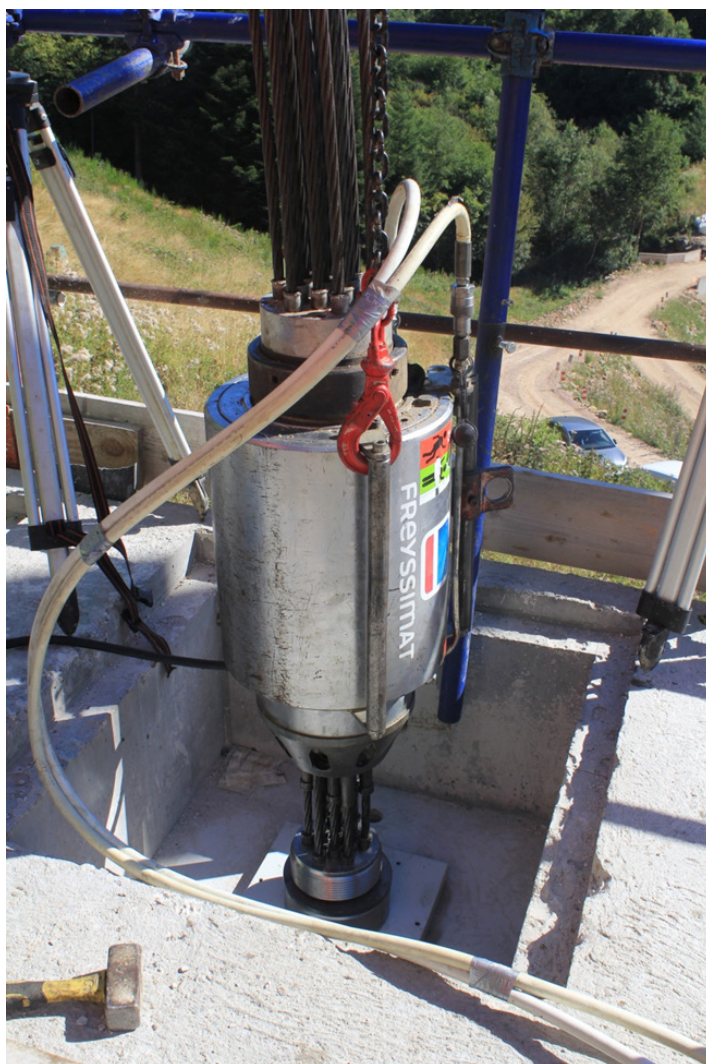
Photo I.4 : exemple de vérin de mise en tension (© Freyssinet)
