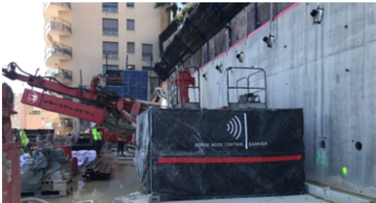
Photo 7.1 : Exemple de dispositif pour réduire les nuisances sonores au forage (© Freyssinet)
