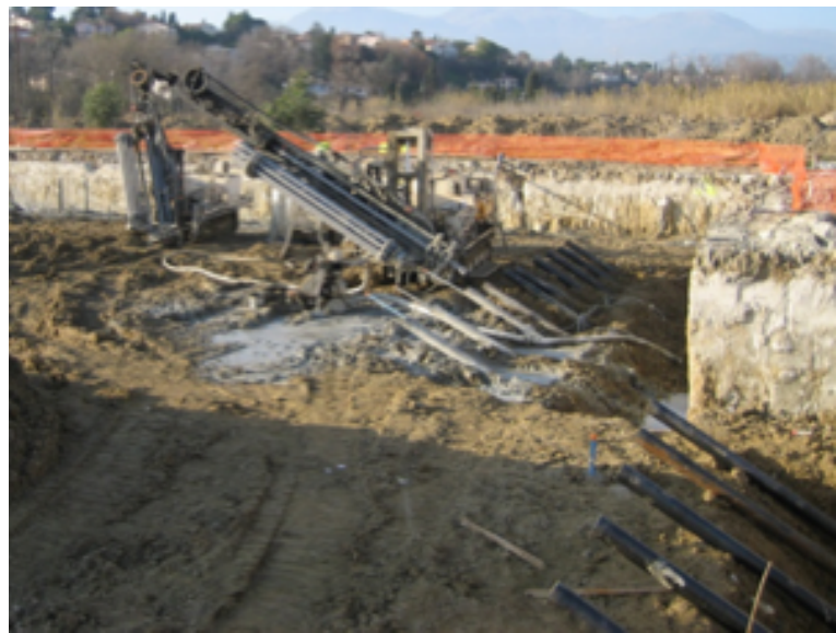
Photo 7.7 : forage avec tubes prolongateurs (© Spie Fondations)
