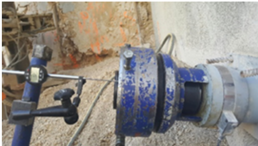
Photo 8.10 : pesage d'un tirant avec tête instrumentée (© Freyssinet)
