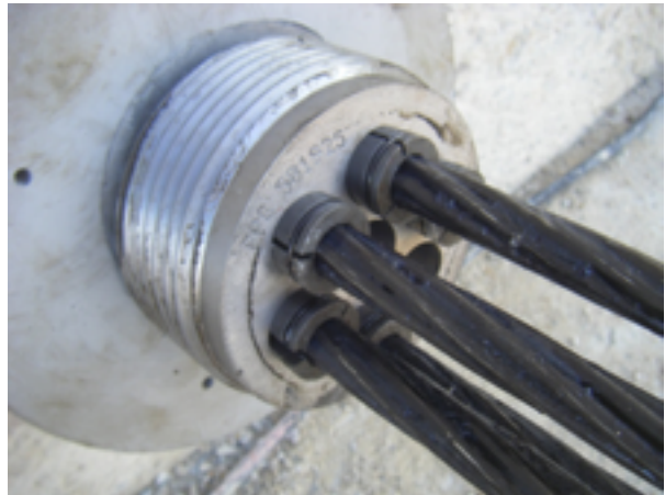
Photo 7.19b : Mise en place du bloc d'ancrage et des clavettes avant mise en tension (© Soletanche Bachy)
