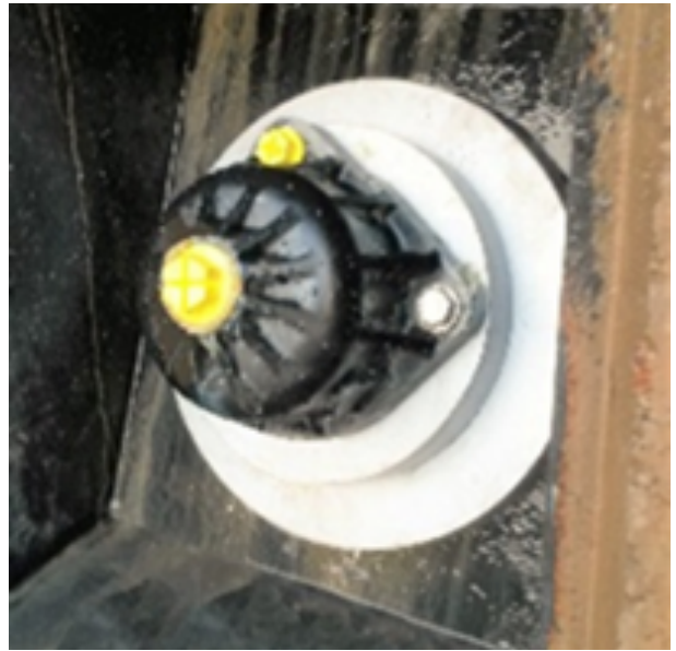
Photo 6.6 : Tête d'ancrage avec protection de type P (© Freyssinet)
