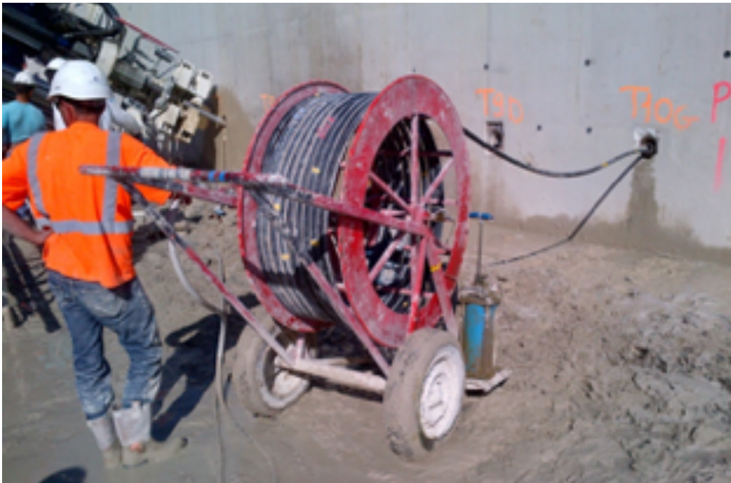
Photo 7.13 : injection de type IRS (©Freyssinet)
