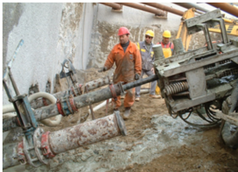
Photo 7.6 : forage sous sas (© Sefi Intrafor)
