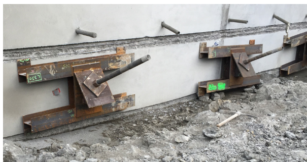
Photo 3.3 : exemple de système d'appui © Franki Fondation
