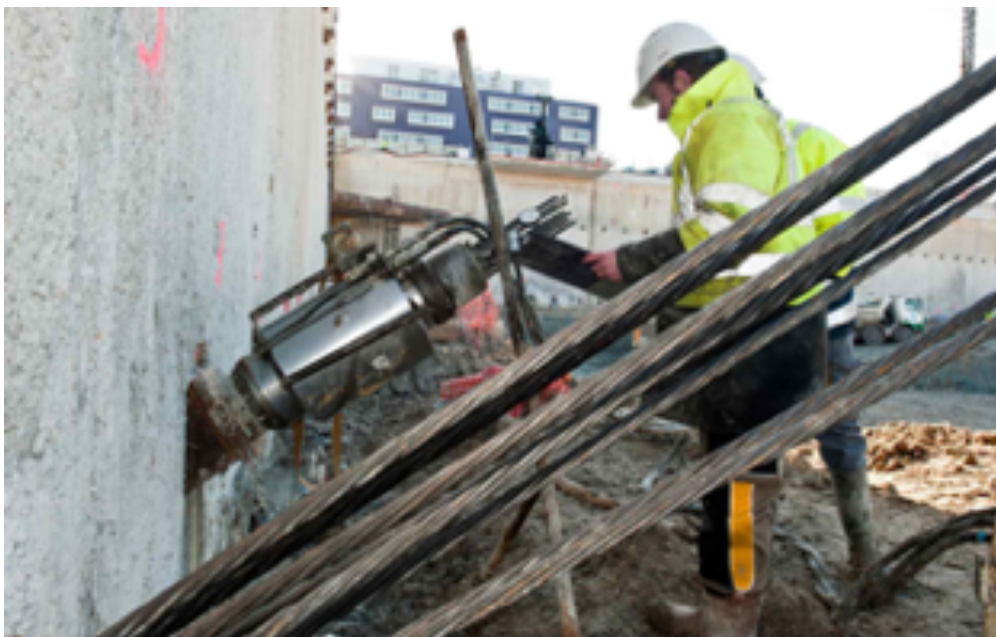
Photo 7.14 : mise en service du tirant (© Sefi Intrafor)
