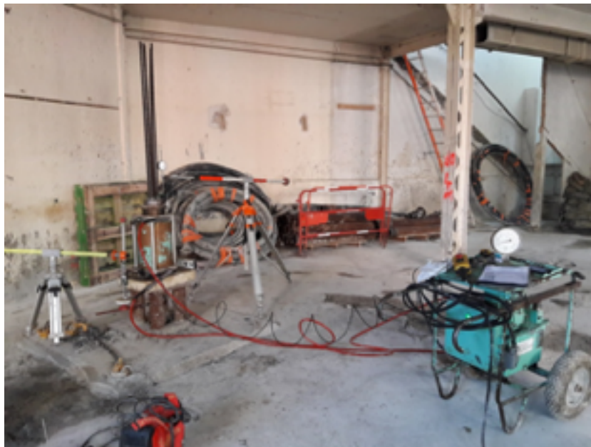
Photo 8.2 : exemple de dispositif pour essai à la rupture (© Spie Fondations)
