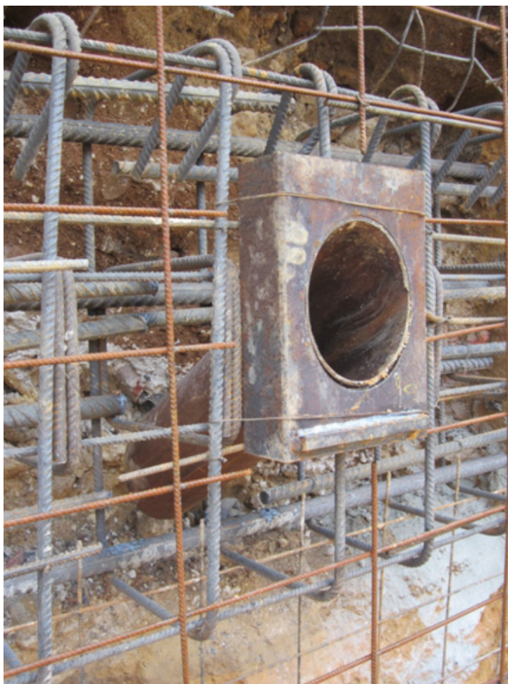
Photo I.2 : Réservation dans voile en béton projeté (© Soletanche Bachy)
