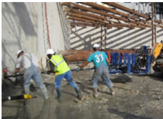
Photo 7.10b : tirant en cours de déroulement dans le forage (© Freyssinet)
