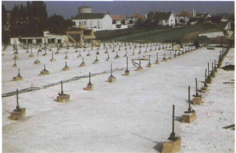
La récupération du coffrage des hourdis intermédiaires n'est pas aisée, notamment dans le cas d'ouvrage situés au-dessus de l'eau ou à une grande hauteur.
