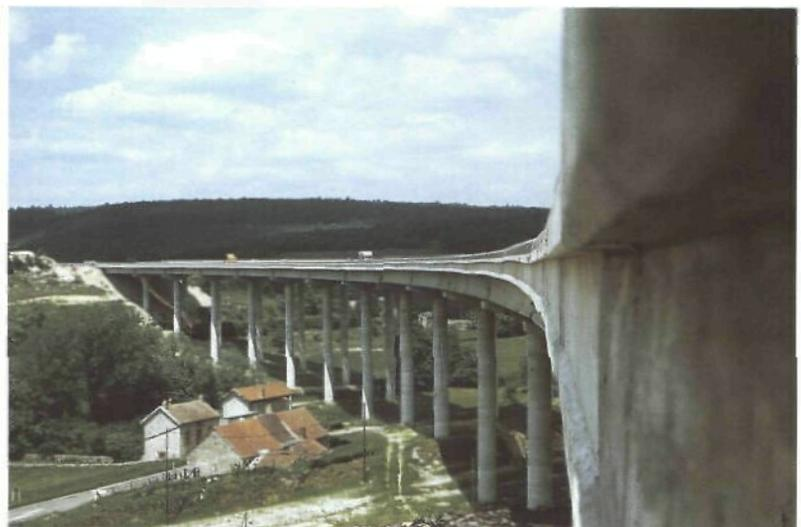
Afin de profiter au mieux de la préfabrication, il est souhaitable de pouvoir implanter les appuis à intervalles réguliers pour réaliser des travées de longueurs égales. Cet aspect peut constituer un handicap pour ce type d'ouvrage.
