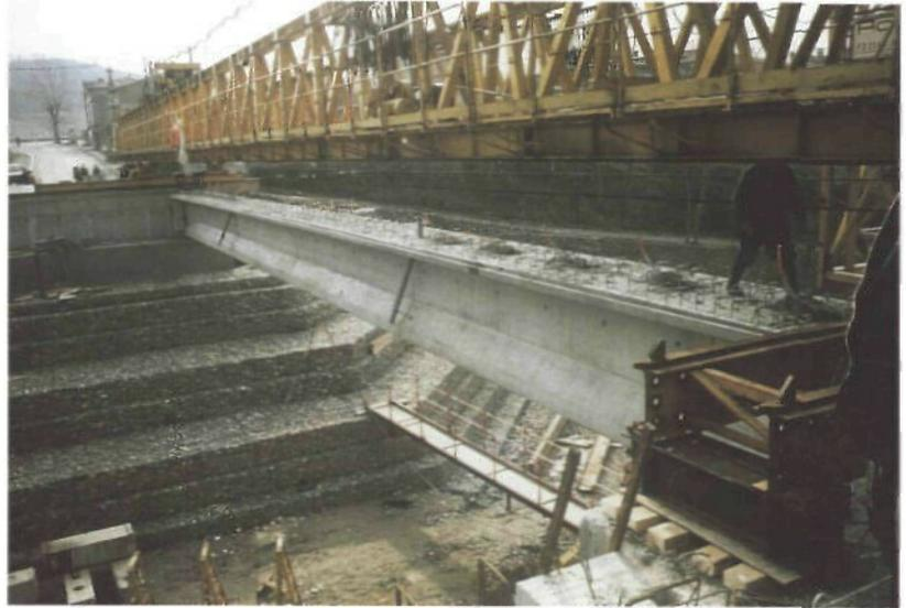
L'intérêt principal du recours à un lanceur provient du fait qu'on ne prend appui que sur les parties de l'ouvrage déjà réalisées, tablier ou piles, ce qui rend la solution totalement indépendante de la brèche à franchir (site accidenté, site aquatique ...).
