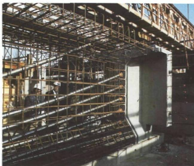
*Ferrailage en place contre l'about préfabriqué*
